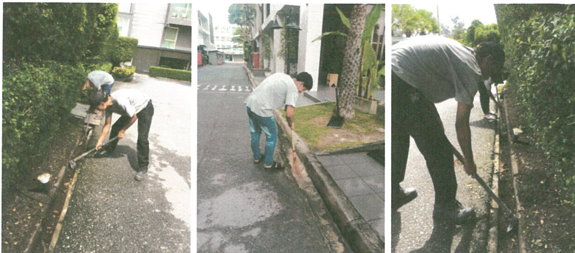
รูปภาพที่ 2.18 การขุดลอกรางระบายน้ำ
